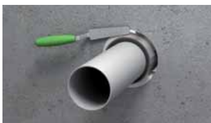
5. Vul de opening met acrylaat, schuim of mortel
