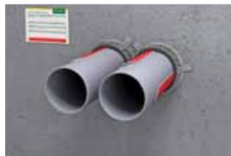
Noll avstånd möjligt mellan kragarna (isolerade rör).
