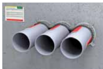
Flera genomföringar (max 3 rör och med 1 Brand krage). Avstånd mellan rör \leq 15 mm.
