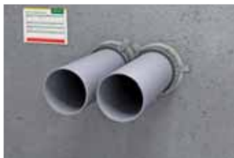
Noll avstånd möjligt mellan kragarna (icke-isolerade rör).
