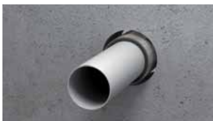
4. Skjut in manschetten i hålet
