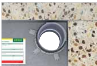
Lämplig för hörn (2/3 brand krage). Avstånd mellan vägg och rör \leq 10 mm.
