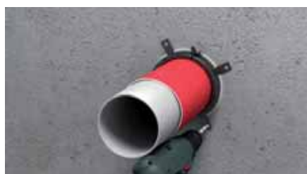
4. Boren (de bevestigingslippen mogen gebogen of geschoven worden)
