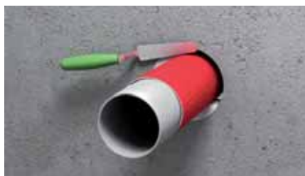
2. Restspleet rookdicht afwerken (bijv. met Pacifyre® FPM of Pacifyre® A Brandwerende Acrylaat Kit)
