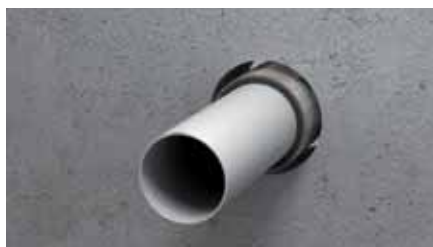
4. Plaats de manchet in het midden van doorvoering
