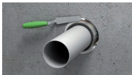
5. Rellene el agujero con espuma o mortero
