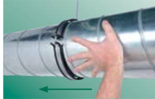
Problemlose Ausrichtung des Lüftungsrohres während Montage
