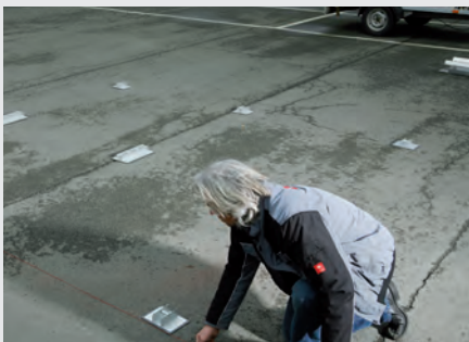
Vorab: Dreiecksmontage & Anbringung der Wind-/Seitenbleche. 1. Schritt: Ausrichtung der Füße auf dem Dach
