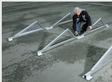
2. Schritt: Verbindung der Einzelkomponenten auf dem Dach
