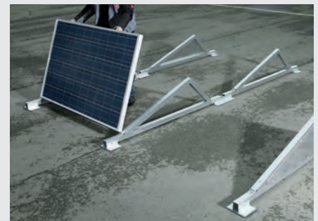
Schritt 3: Montage der Module und End-/Frontbleche
